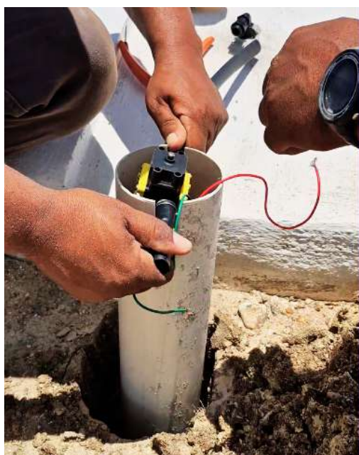
Bomba de água sendo instalada
