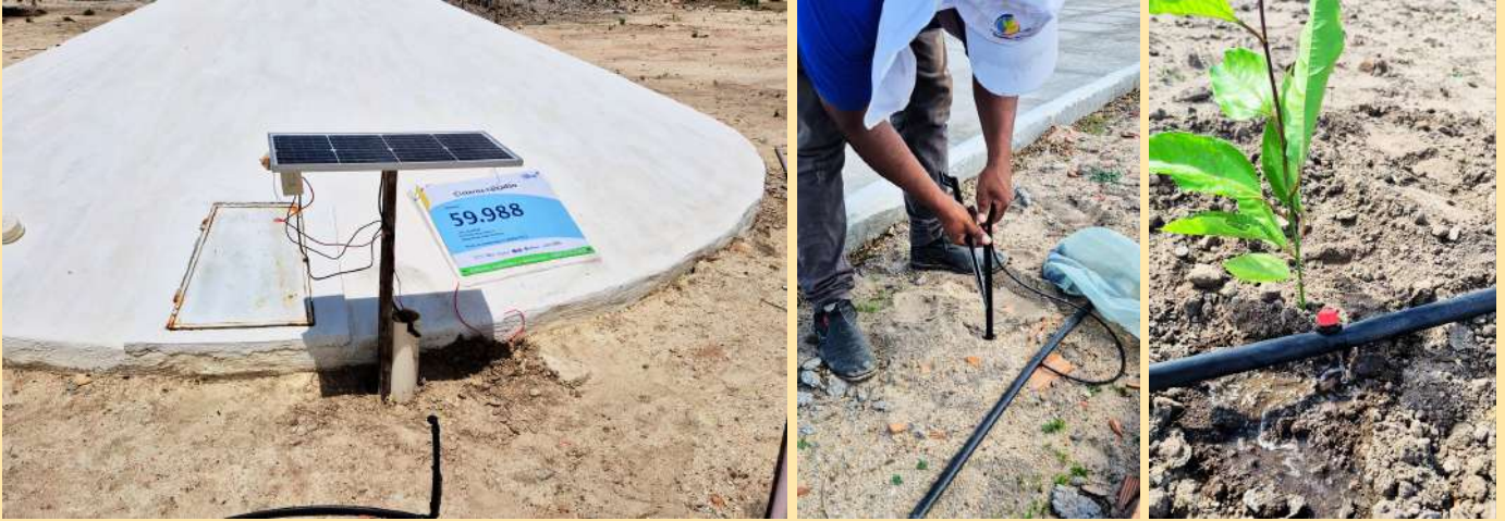
Placa Solar na cisterna, Deivi colocar aspersores, gotejamento funcionando
