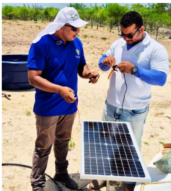
Deivi e José montam o painel solar
