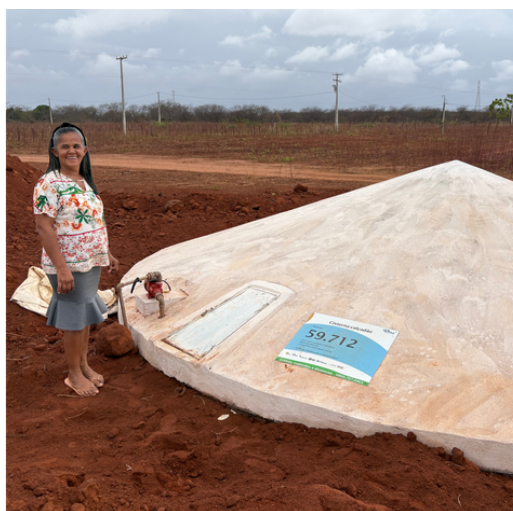
Cisternas com capacidade de 52 mil litros
