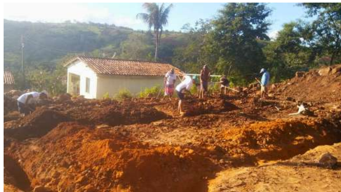
Construção da sede da AMAQUI
