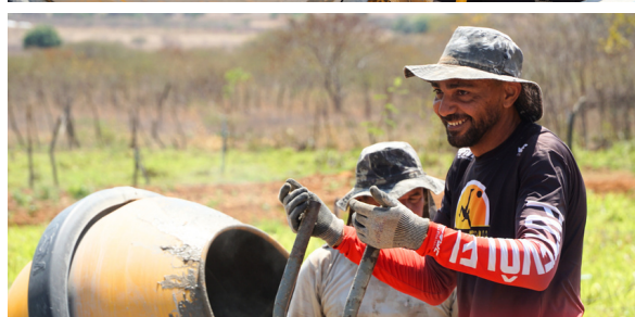
Equipe de cisterneiros em ação!
