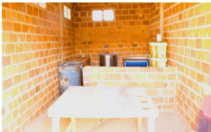
Obras iniciais do galpão para armazenamento do mel.
