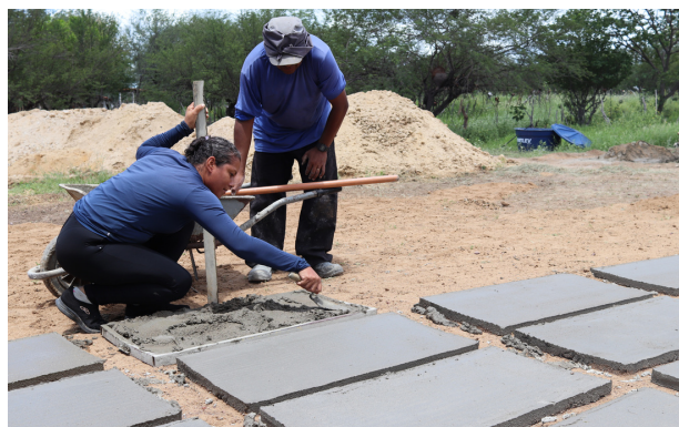
Isis Laila fazendo as placas de cimento.
