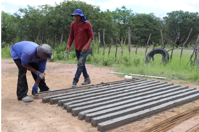
Instrutor Edivandro orientando a construção dos caibros.
