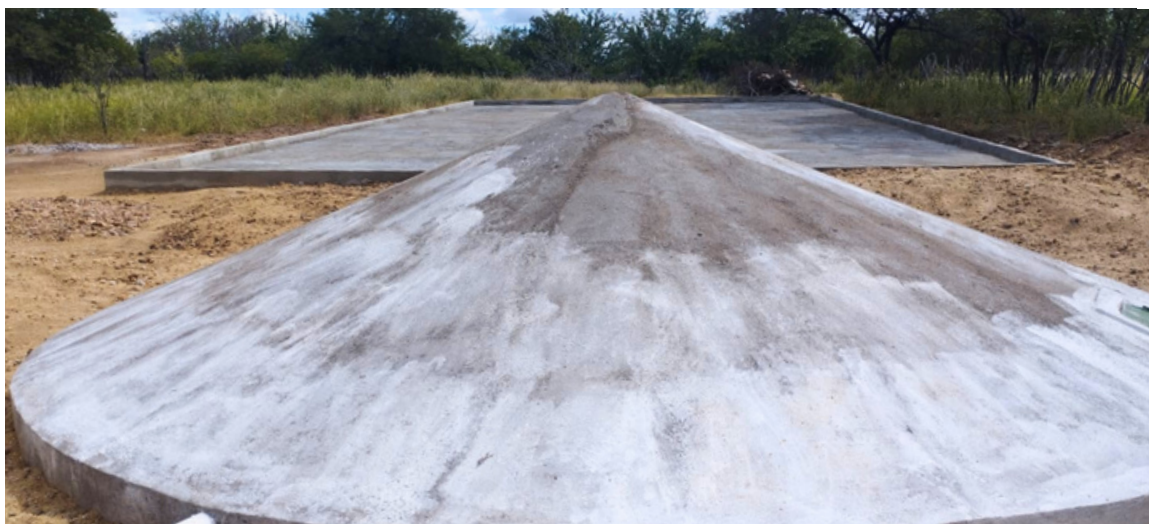
Cisterna de produção em processo de finalização.
