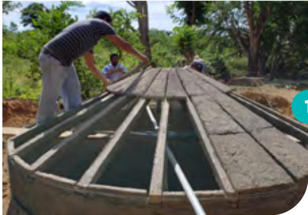
Após a montagem das vigas com um dos dois sistemas de pilar central, colocamos as placas do teto, uma a uma, apoiando-as nas vigas, com o lado liso voltado para dentro.
