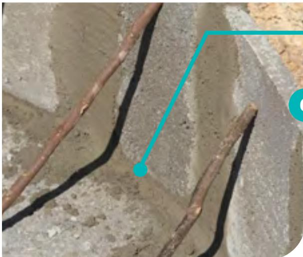
Fazemos o rejunte entre as placas, colocando um pequeno pedestal ou borda que segura bem as placas no chão em ambos os lados, para fixar as placas na base.
