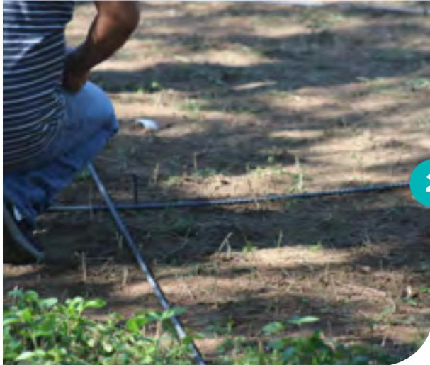
Usar o ferro de 8mm com 6m de comprimento para formar o círculo que foi desenhado, juntando as pontas do ferro com arame e uma estaca.
