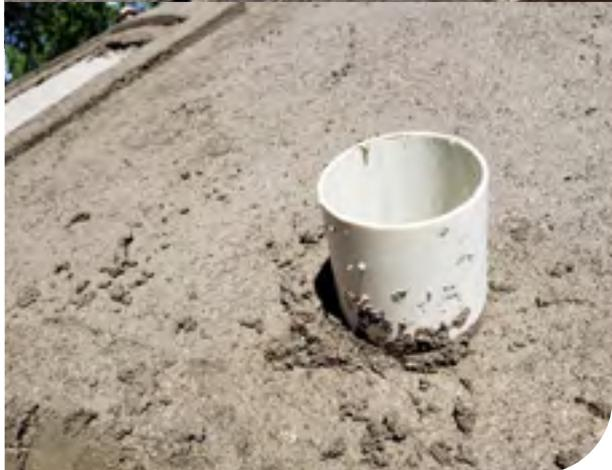
Colocamos a placa de teto que tem o furo para entrada de água no local mais conveniente para receber a água. Por exemplo, próximo à calha do telhado para canalizar a água da chuva.
