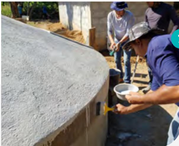
Pintamos o exterior da cisterna de placas com cal ou tinta à base de água. Isso reflete a luz solar, reduzindo a temperatura no interior da cisterna, protegendo da umidade e reduzindo a possibilidade de futuras rachaduras e dilatações.
