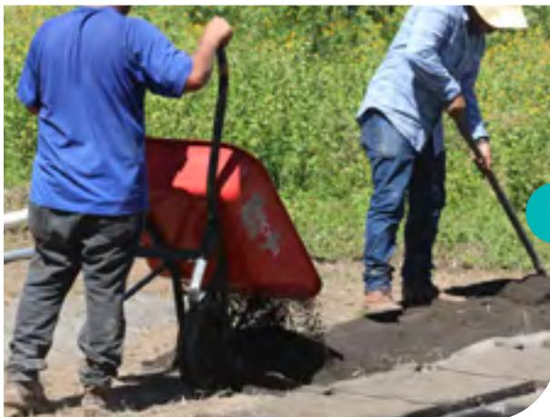
Como foi feito com as placas, começar montando uma cama de areia nivelada ao solo onde serão construídas as vigas.
