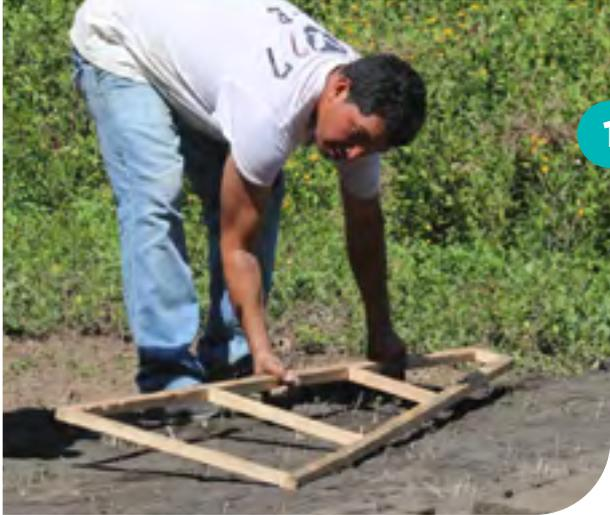
Preencher os moldes com o concreto, espalhando bem por toda a área e tirando o excesso com uma madeira.
