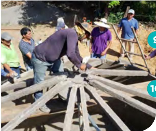
Coloque concreto nos ganchos entre a tampa e os ganchos. Deve ficar bem firme porque removeremos o pilar central depois de cinco dias.
