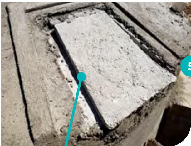
Ao redor da placa onde será instalada a porta, fazemos uma moldura para evitar que a água escorra e entre na cisterna diretamente por cima, protegendo-a da terra e facilitando a colocação da porta.
