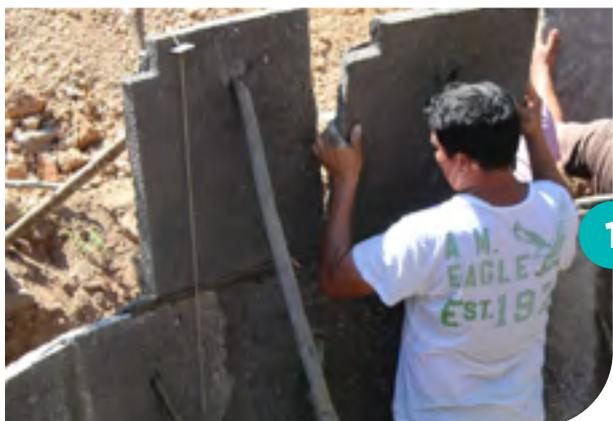
Seguimos da mesma maneira para colocar a segunda fileira de placas da parede, e usando o sistema de escoramento que foi escolhido. As placas da parede superior são colocadas sobrepondo as juntas da primeira fila de placas para fechar toda a parede.
