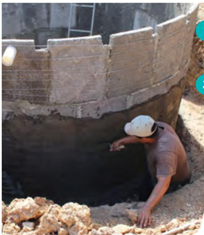
1 Escove as paredes para retirar a areia solta e faça duas camadas grossas, rebocando até cobrir toda a parede. É importante cobrir bem todas as voltas do fio de arame.
