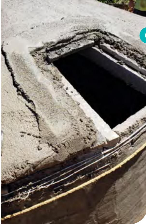
Com um material flexível como uma mangueira fina, circundamos a cisterna na parte superior da parede, a cerca de 10 centímetros do limite com o início do teto, e fazemos um pedestal ou flange, preenchendo esse degrau com a massa de reboco. Esse acabamento é um reforço para o local onde são assentadas as vigas.
