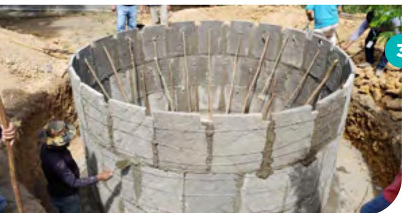
Levantamos a terceira fileira de placas de parede da mesma forma que as anteriores, usando o fio de prumo e unindo as juntas perfeitamente por dentro e por fora e supervisionando as linhas e placas.
