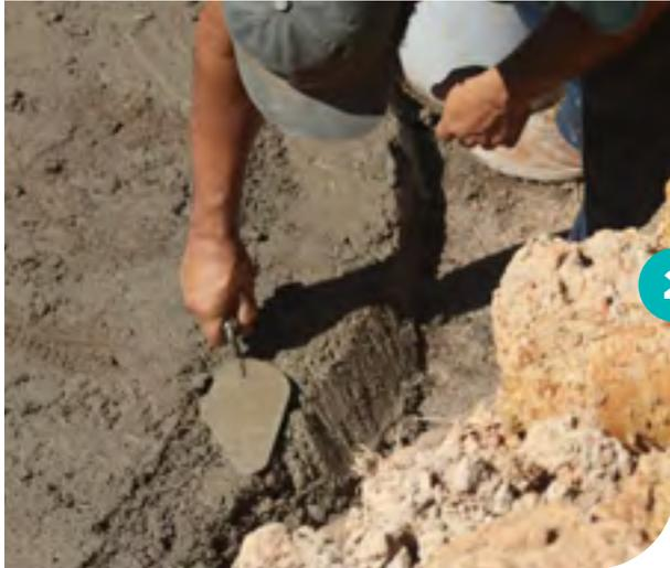
É importante ir nivelando o piso na medida em que avança na construção da estrutura, especialmente na parte mais externa.
