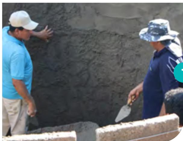
Com a massa, rebocamos o interior, cobrindo muito bem toda a parede. Alise para fazer um bom acabamento. Este reboco não deve ficar muito fino. É importante ter o cuidado de não deixar nenhuma parte da parede sem reboco e ter atenção para não haver fissuras.
