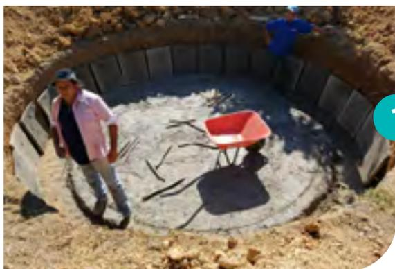
Uma vez escolhido o sistema de escoramento, preparamos a argamassa para colocar as placas e cuidadosamente as transferimos para o interior do poço, apoiando-as nas paredes.
