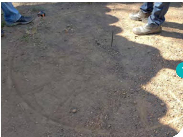
Em um lugar amplo e limpo, diferente do espaço da cisterna, riscamos no chão um círculo com 1,75m de raio, a partir do centro do buraco, totalizando 3,5metros de diâmetro. É importante o piso estar bem compactado.
