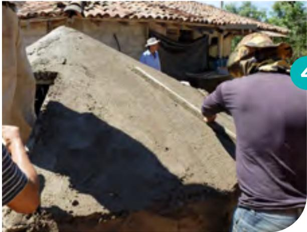
Completamos o reboco de toda a cisterna com o mesmo material das paredes externas.
