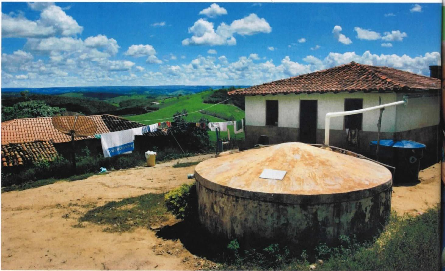
e escovar os dentes durante os 8 meses de estiagem. Com um sistema simples de captação de água da chuva através de calhas no telhado, a cisterna tem capacidade para armazenar até 16 mil litros de água, o suficiente para uma família de 5 pessoas. “A primeira cisterna resolveu o problema da água da casa, mas não o problema da horta”, lembra.
